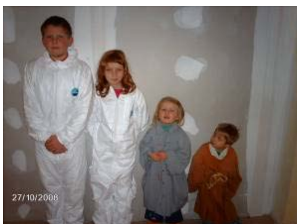
Réfection du couloir
