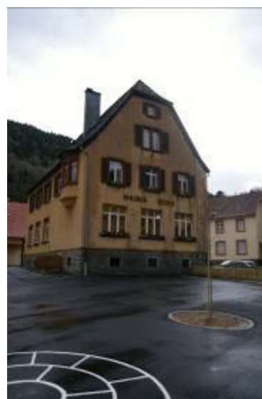
La cour rénovée
