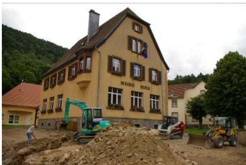
Le début du chantier
