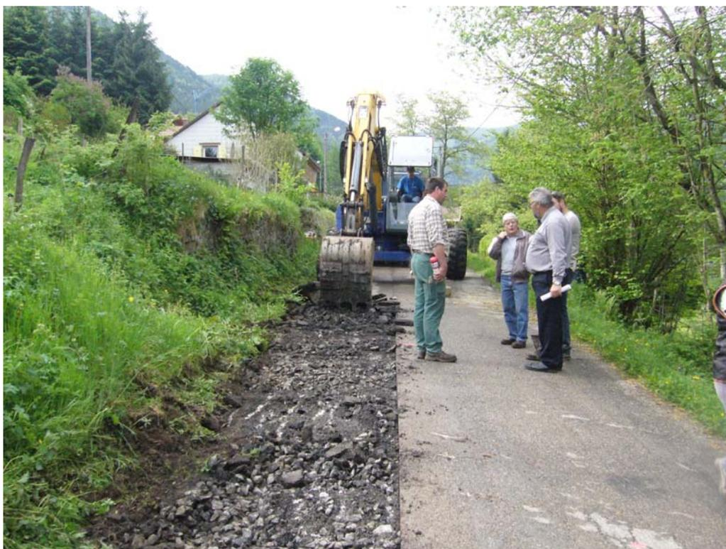
**L'ouverture de la rue du Haut-Mittlach avant la pose du réseau**
