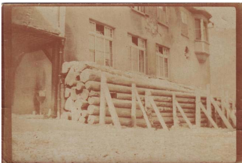
Le renfort des troncs d'arbre en gros plan près du préau. (Remarquez que la petite vasque est toujours encore en place)
