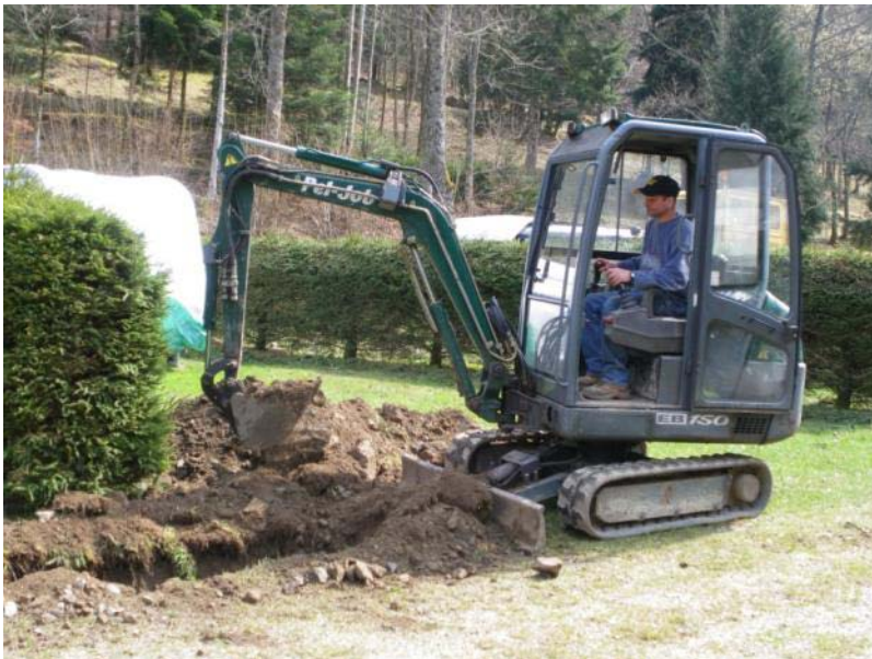
La préparation de la tranchée
