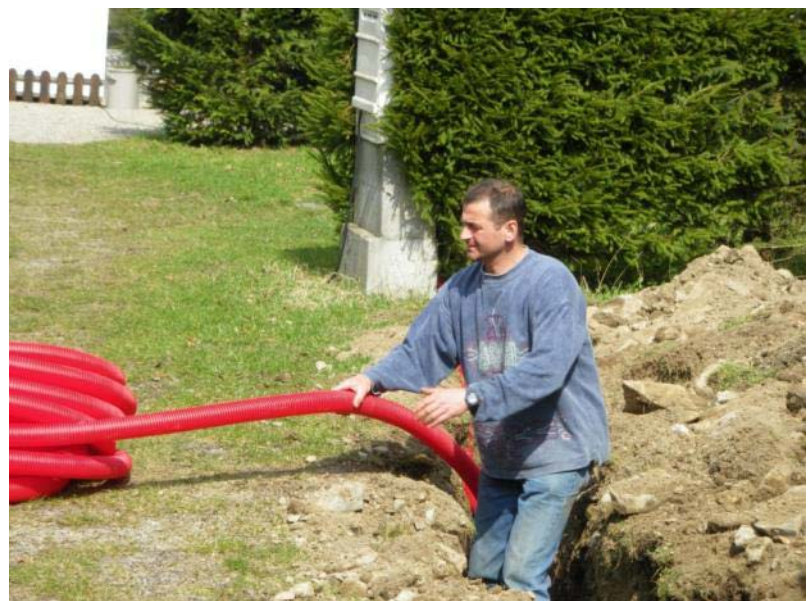
La pose des tuyaux
