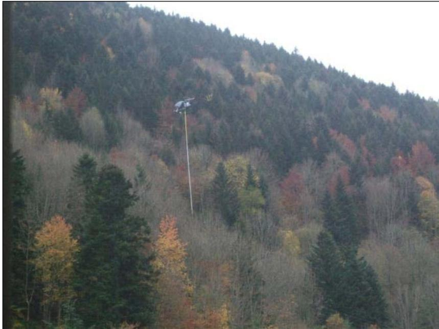
Si dans un premier temps la coupe des arbres aux alentours des lignes s'est faite d'aplomb, la semaine suivante, l'entreprise s'est attaquée - toujours de manière ailée et avec cette fois une large lame horizontale, équipée de 6 scies circulaires d'un fort diamètre - à la coupe des arbres et arbustes au sol.
