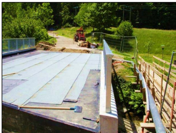
En cours de travaux, plusieurs couches de revêtement ont été nécessaires
