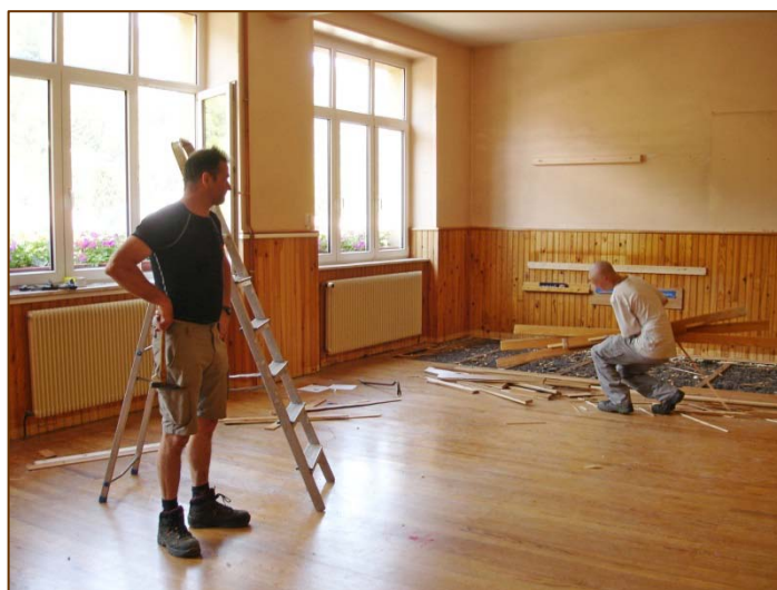
Début des travaux
