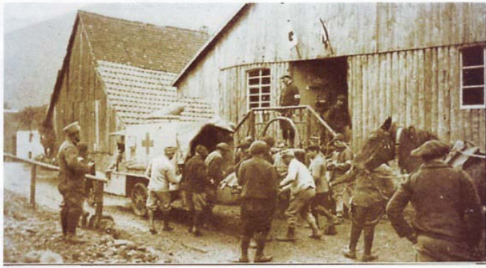
A 'Poste de Secours' in the Valley of the Fecht. (Un poste de secours dans la vallée de la Fecht).
