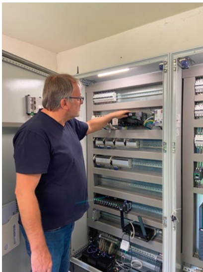
La nouvelle armoire électrique à la station de pompage.
